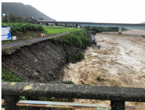
令和元年（2019年）10月台風19号により堤防が欠損した早川（田屋地区）
