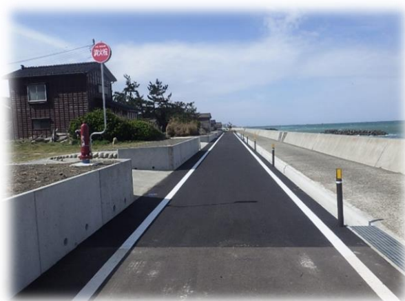
新設された市道大和川海浜線
