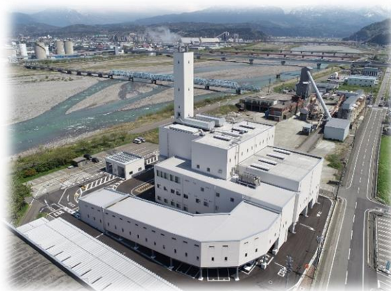
令和2年（2020年）4月から本格稼働した新ごみ処理施設
