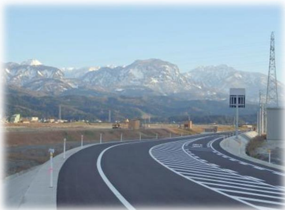
令和 2 年 3 月開通 松糸・今井道路西中バイパス
